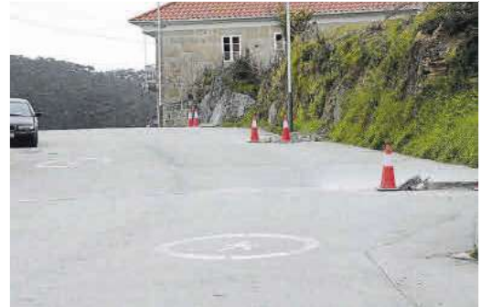
Carretera O Viso-Igrexario.
