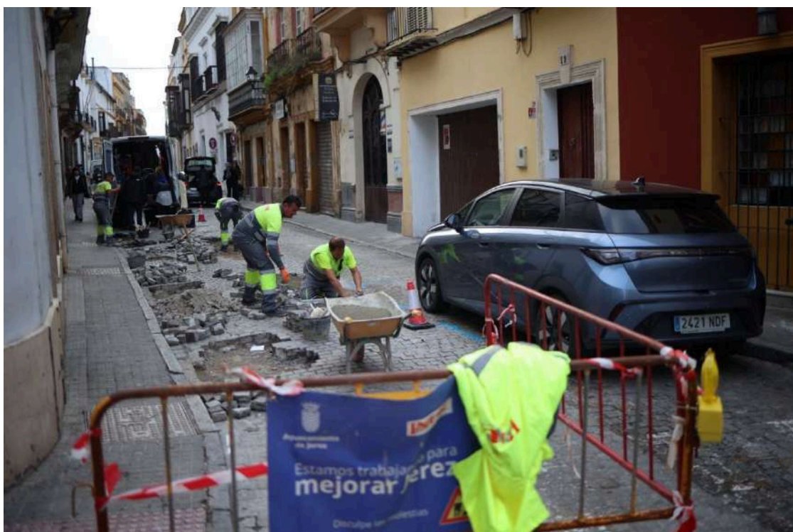
Trabajos de reparación de la calzada y el adoquinado de calle Caballeros, este martes en Jerez. MANU GARCÍA
