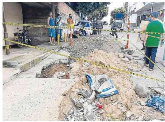
Habitantes del municipio histórico denuncian que algunas vías intervenidas no han sido arregladas. / Foto: Archivo
