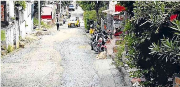
En algunos barrios, las tuberías antiguas han ocasionado colapsos. / Foto: Archivo
